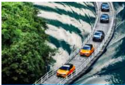
ถนนลอยน้ำด่านสิงโต
